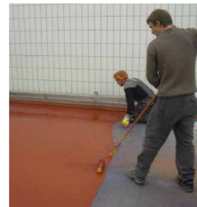
Bereits nach sieben Tagen kann Ihr Ucrete-Belag fugenlos auf den Nuttschichtbeton aufgetragen werden. 24 Stunden später sind beide Schichten voll ausgehärtet und der Boden einsatzfähig.
