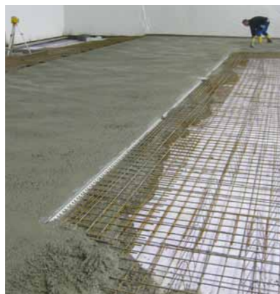
Auch das gehört zum Komplettpaket von abt: Gemeinsam mit unserem Kooperationspartner, HIT GmbH aus Schneverdingen, wird nach dem patentierten CCf®-System ein spezieller Trag- und Nuttschichtbeton mit einer statisch nachgewiesenen konventionellen Bewehrung eingebracht.
