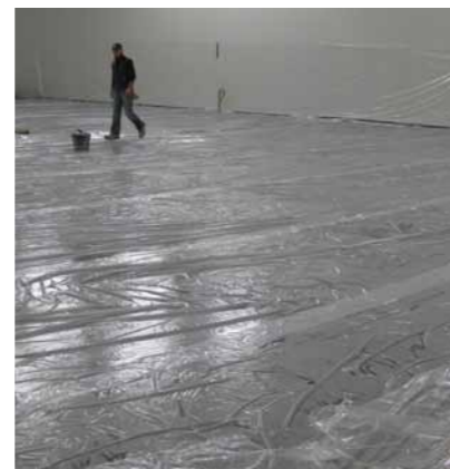
Die Betonschicht wird anschließend mit einer Folie bedeckt und so vor Austrocknung geschützt. Damit verhindern wir spätere Schwindrisse.
