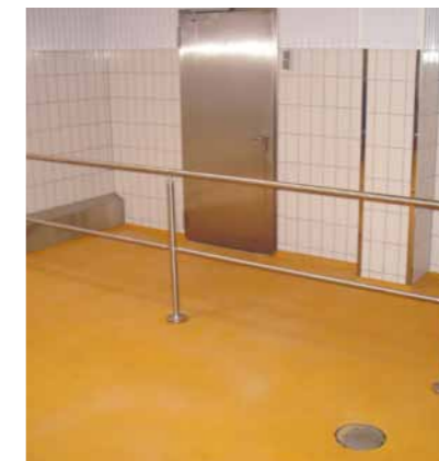
Anfahrtschutz, Wandabschlüsse, Abläufe: Alle Elemente bilden in dem abt-Konzept eine feste Einheit mit dem Boden.
